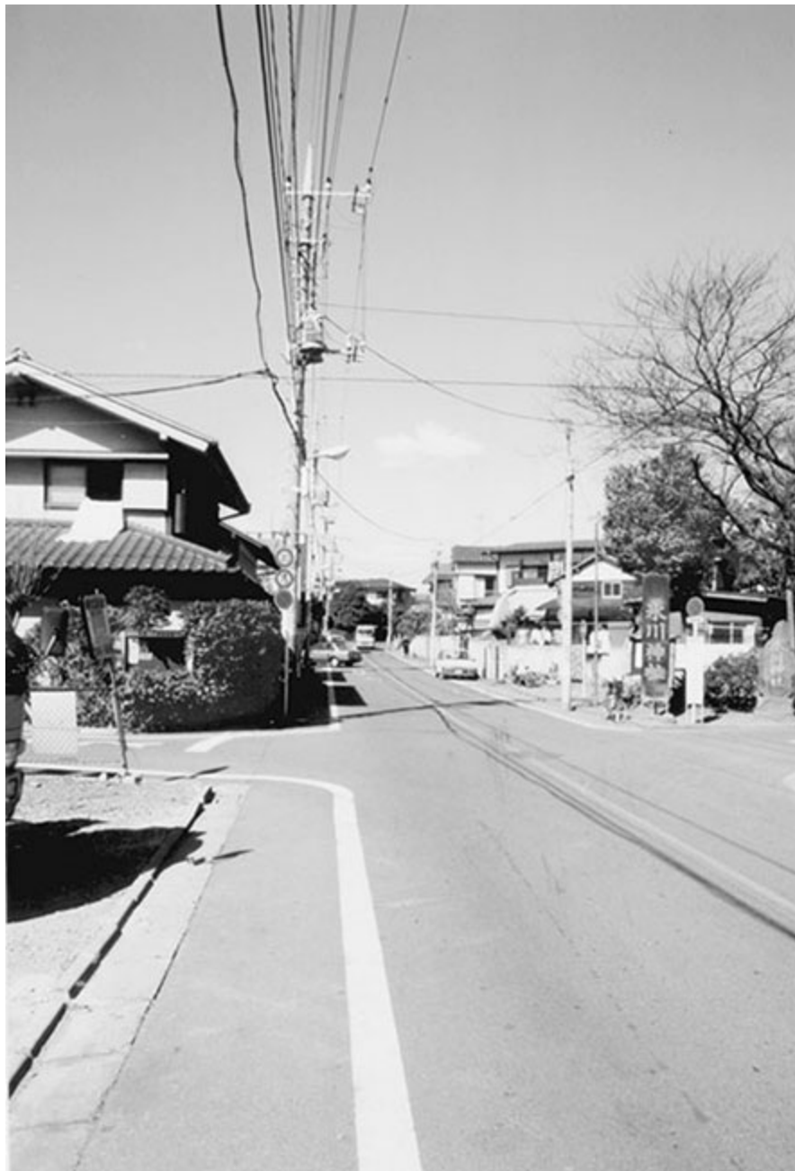
Bardzo Szeroka Ulica (ale nie tak, żeby dać jej nazwę). Nieodłączny element japońskiego pejzażu – wszechobecne kable.
