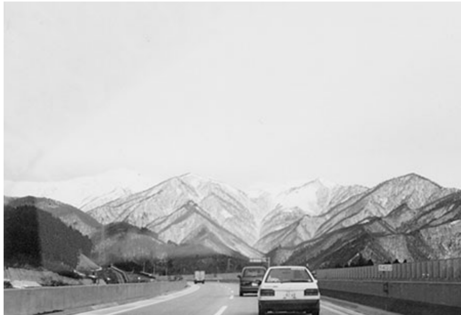
Autostrada, jak to w górach, biegnie po betonowym wiadukcie, zejść nie ma jak.
